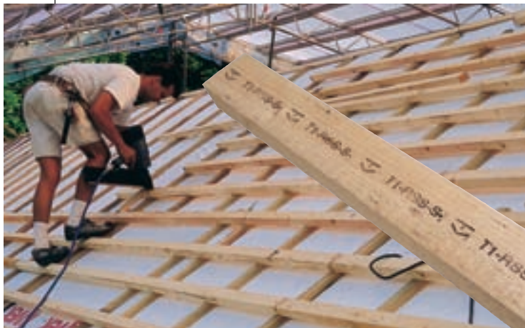
Figur 1 Taglægter skal være T1-mærket, og mærket med T-virkeordningens logo samt producentnavn (evt. forkortet).
