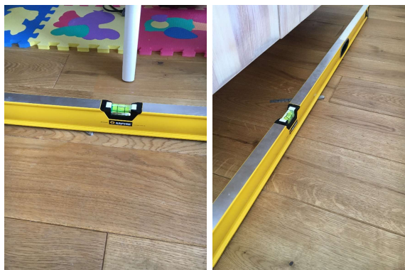
Figur 91 For bræddegulve må der forventes nedbøjninger på op til 2 mm målt med et 2 m retholt. For strøgulve måles nedbøjning mellem stroer eller mellem opklodsninger. For svømmende gulve er de største nedbøjninger afhængige af mellemlagets eftergivelse og eventuelle lunger i undergulvet.
