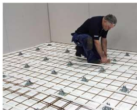
Indstøbt i beton
