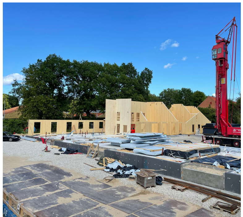
Lastbil aflades straks og "pakkerne" placeres på byggepladsen
