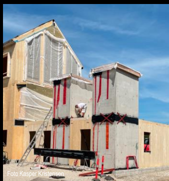
A. Præfabrikerede, støbte vådrumsmoduler, stablet ovenpå hinanden
