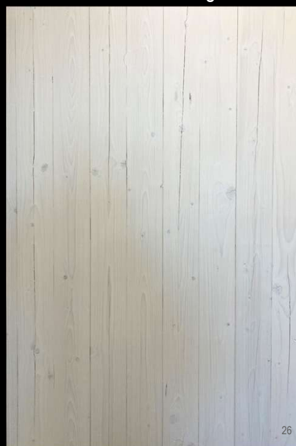
Svindrevner mellem og i lameller
