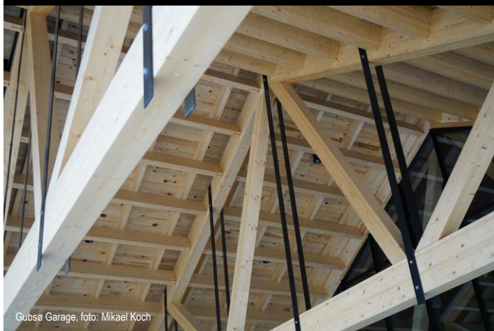
Fritliggende spær, type T2 Taghældning 35°
