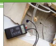
Figur 10. Håndholdt måleinstrument tilsluttet føler i et indstøbt plastør i et betonlag.
