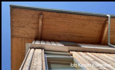
Brettstapel (kantstillede brædder) i udhæng
