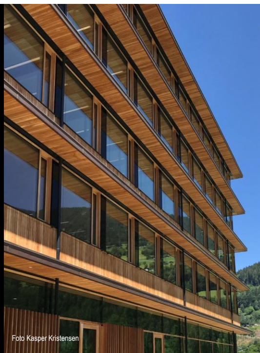
Illwerke Zentrum Montafon, Voralberg Østrig, 2019
