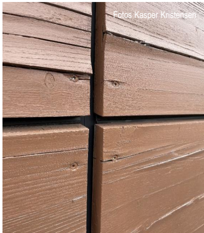
Limede plader på facade efter få år
